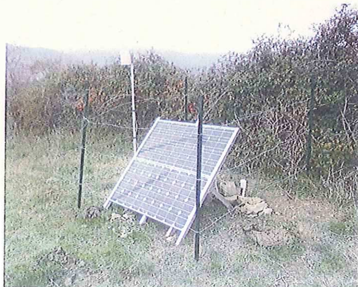
Figura 3: Foto della stazione sismica brb installata nel comune di Barberino del Mugello e attiva dall'Aprile del 2008, i cui dati sono trasmessi al Laboratorio di Geofisica Sperimentale del Dipartimento di Scienze della Terra.
